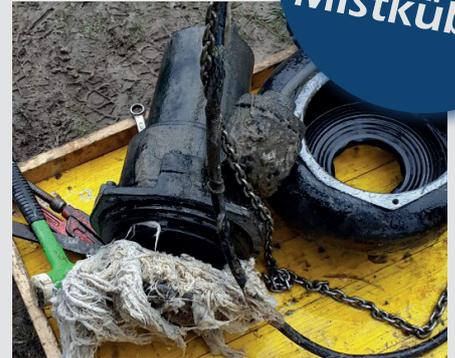
Diese verstopfte Kanalpumpe musste in Gollarn von den Mitarbeitern des GAV ausgebaut und instandgesetzt werden.
